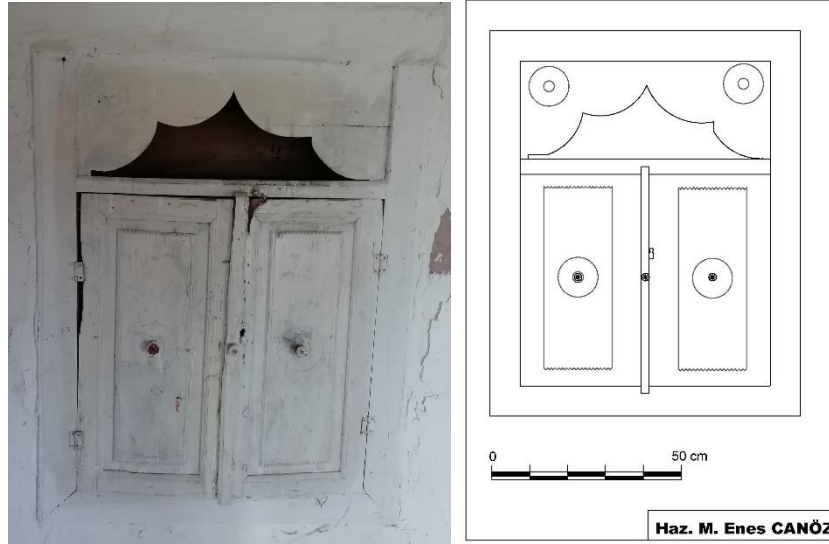
Foto 16: Hasan Mızrak Evi güney oda gömme dolabı (Canöz Arşivi).
