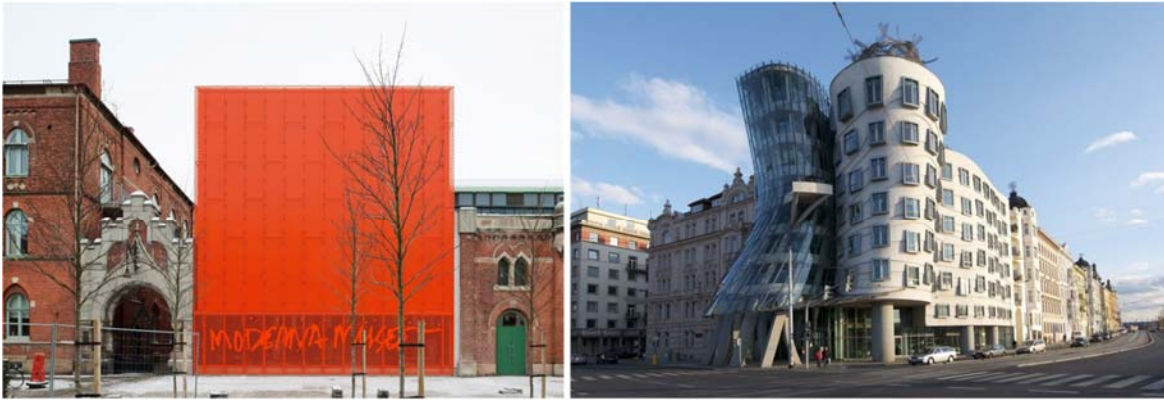
Şekil 11. a) Malmö Modern Müzesi (İsveç) [57] ve b) Dans Eden Ev (Prag) [58] (a) Malmö Modern Museum in Sweden [57] and b) Dancing House in Prague [58])
