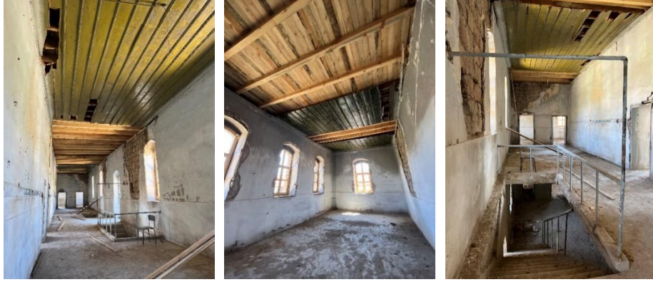
Şekil 23. Ana Bina'nın dersliklerinden ve koridorundan görünüşler (Yazar tarafından çekilmiştir, 15.04.23)
