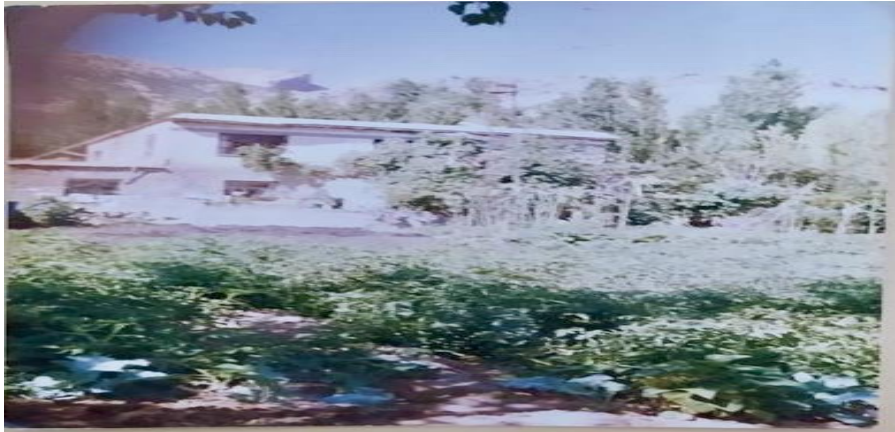
Şekil 5. 1975 Lice Depreminden Sonra Yapılan Evden Biri
