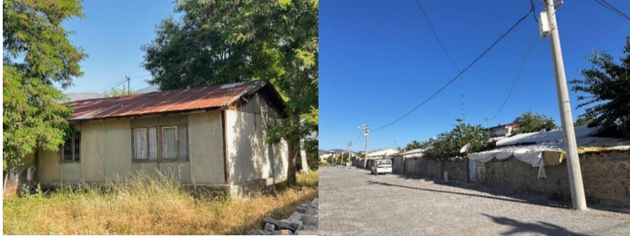
Şekil 6. Depremden Sonra Yapılan Baraka Evleri (Arslan ve Ünlü, 2010).
