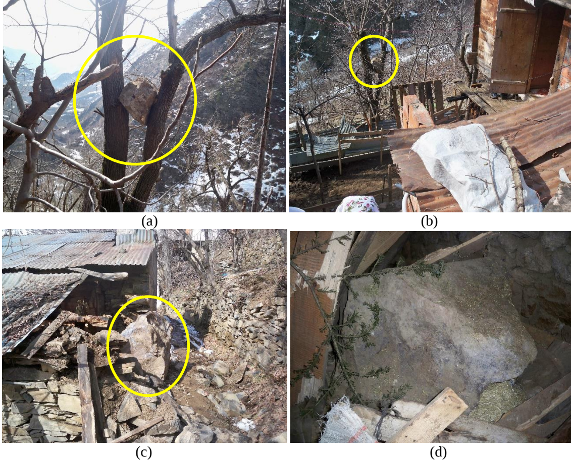
Şekil 6: 2011 yılı şubat ayında Ortaköy Yenice mahallesinde düşmüş olan kaya bloğu parçalarının bazıları konut ve ahır çatısından sonra yaptığı sıçramanın ardından ağaç dallarına takılı kalmıştır (a ve b). Kaya bloklarının konut avlusuna ve ahıra ulaşmış olanlarının her birinin 1.5-2.0 m 3 civarında hacme sahip olduğu görülmektedir (c ve d).
