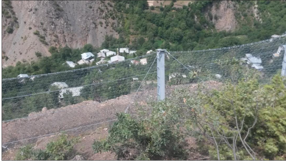
Şekil 9: Artvin İli merkez ilçesi, Ortaköy, Yenice mahallesinde imalatı yapılmış olan 3.000 kJ enerji sönmülemeli kaya bariyerinin kaynak zon üzerinden görünümü.
