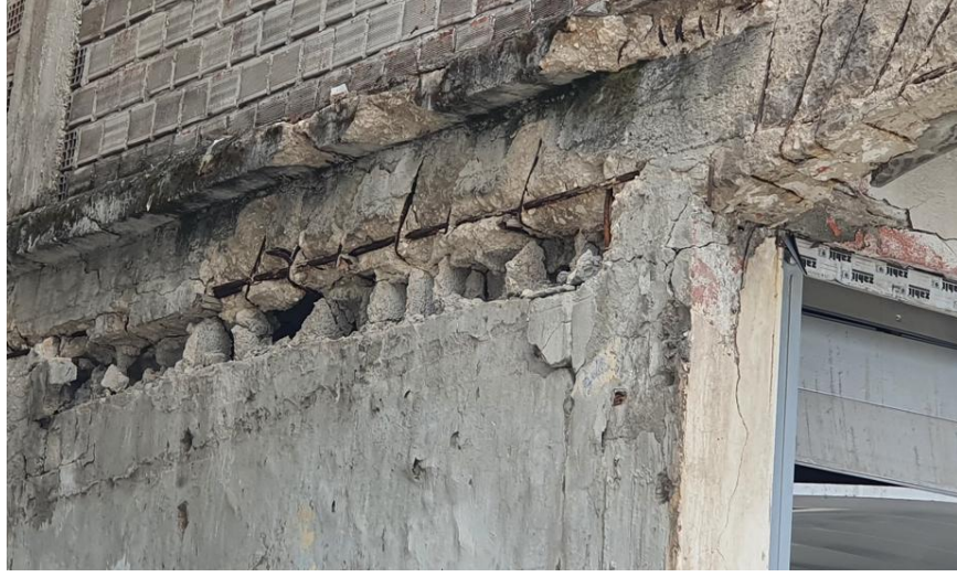
Şekil 3. Betonarme Kiriş ve Donatılar
