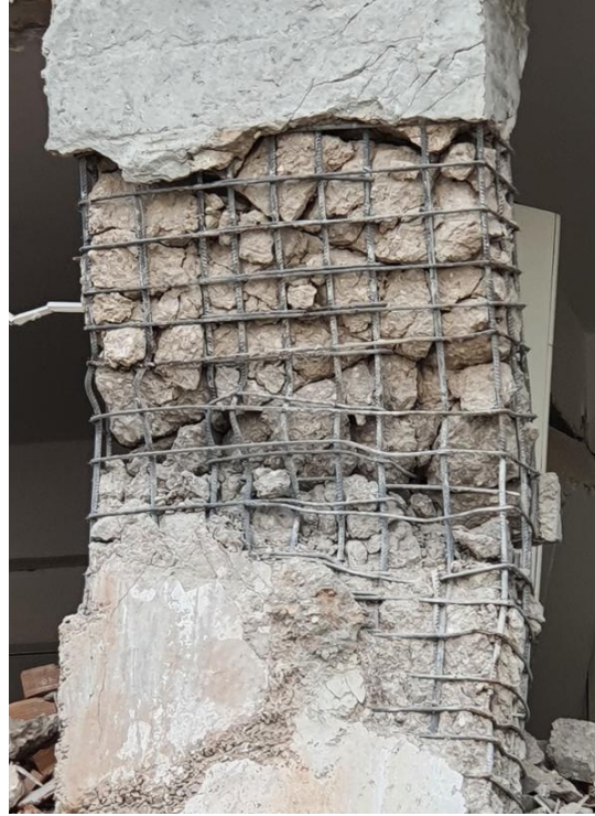
Şekil 4. Betonarme kolon ve donatılar
