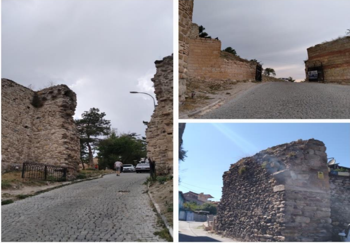
Resim 3: Kütahya Kalesi İç Kale, Yukarı Kale ve Aşağı Kale Kapıları
