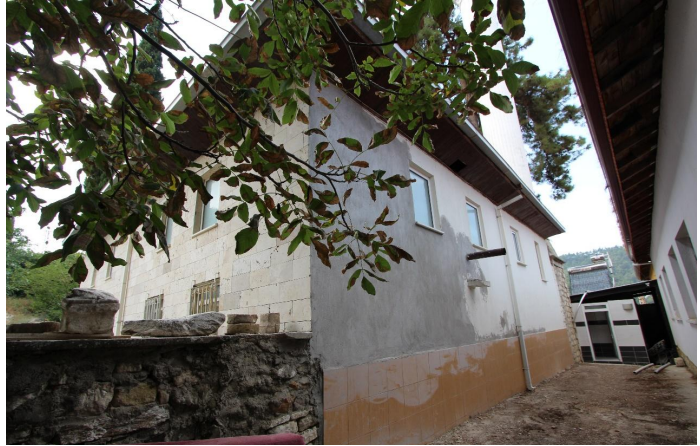
Fotoğraf 15: Hisarköy Camisi Doğu Cephesi
