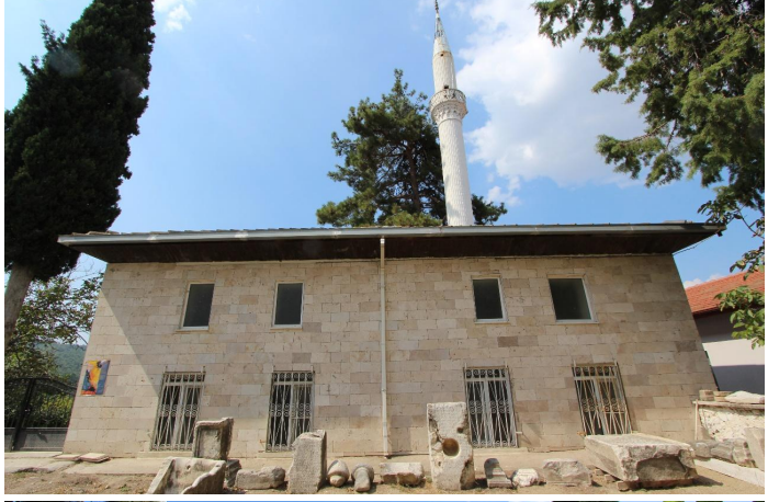
Fotoğraf 13: Hisarköy Camisi Güney Cephesi
