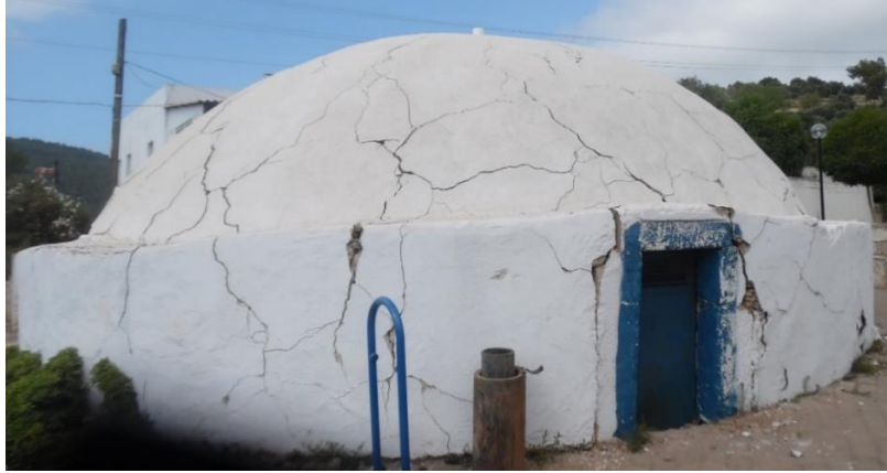
Şekil 2: Depremden Sonra Ağır Hasar Alan Sarnıç (Bodrum Belediyesi-Koruma, Uygulama ve Denetim Bürosu, 2017)
