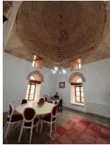
Kubbeli toplantı odasında dikdörtgen, sivri kemerli, mazgal pencere
