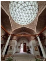
Giriş eyvanında cam jeodezik kubbe
