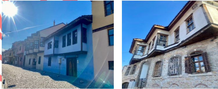
Şekil 3. Geleneksel Uşak Evleri (Traditional Usak Houses) [13]
