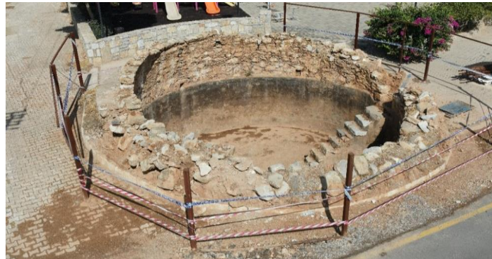
Şekil 3: Deprem Sonrası Zamanla Çöken Kubbe (Yıldız, 2024)
