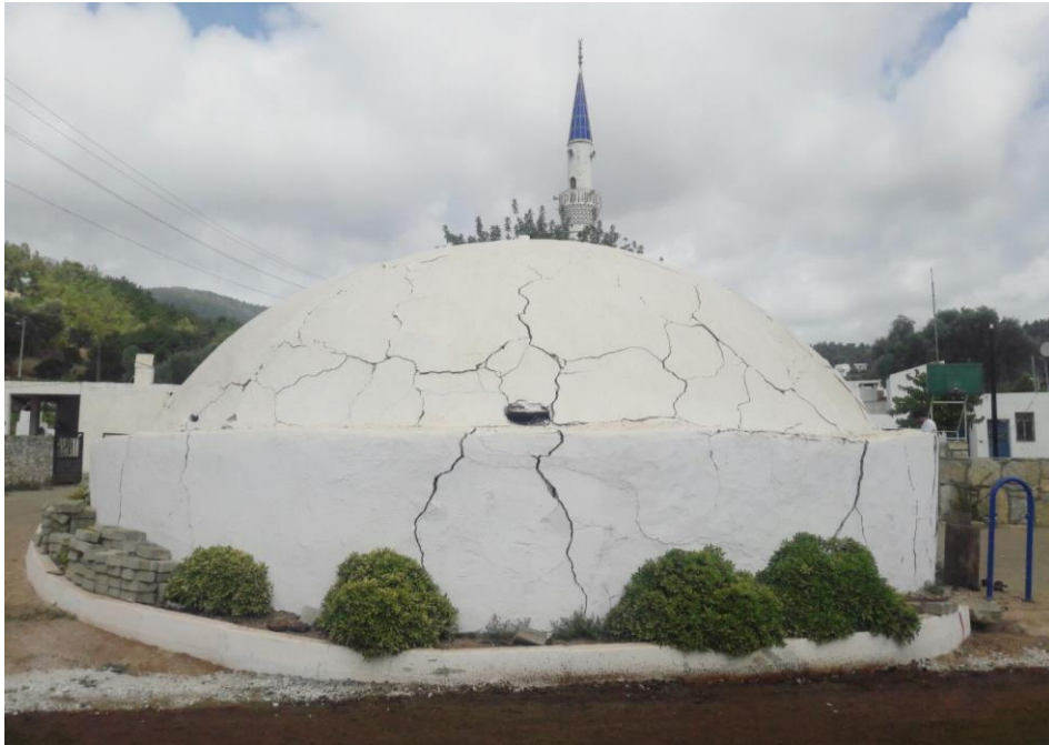
Şekil 5: Kireçle Sıvanan Dış Cephe (Bodrum Belediyesi- Koruma Uygulama ve Denetim Bürosu, 2017)
