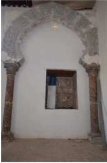
Fotoğraf 29. Güneydoğu kanadın güneybatı köşesinde bulunan kemer kütesinin genel görüntüsü
