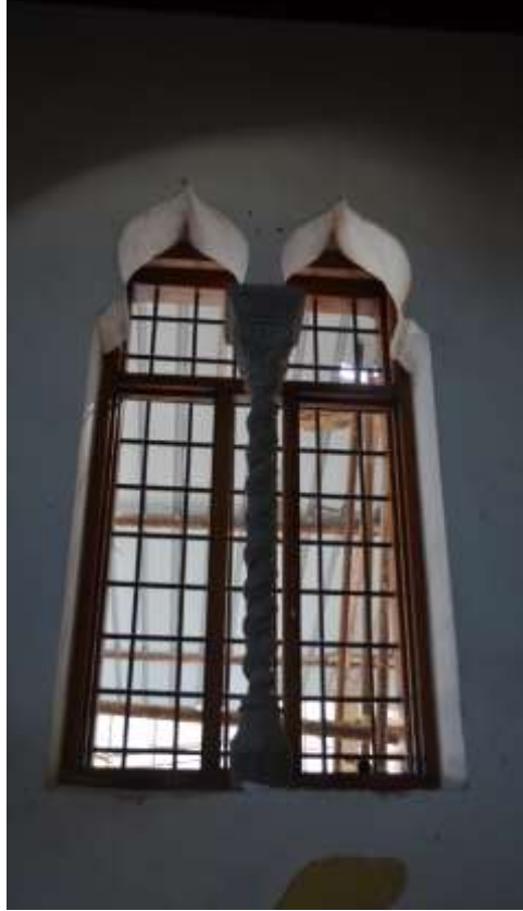
Fotoğraf 25. Harim güneybatı duvarındaki ikiz pencereden detay
