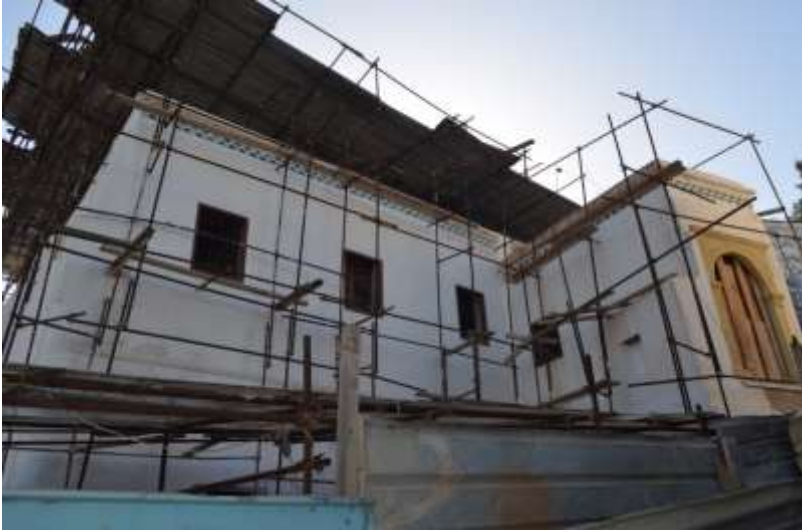
Fotoğraf 10. Kuzeydoğu cephedeki pencerelerden detay.
