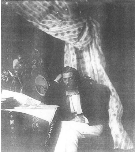
Ek 6. Mihail Obrenoviç
