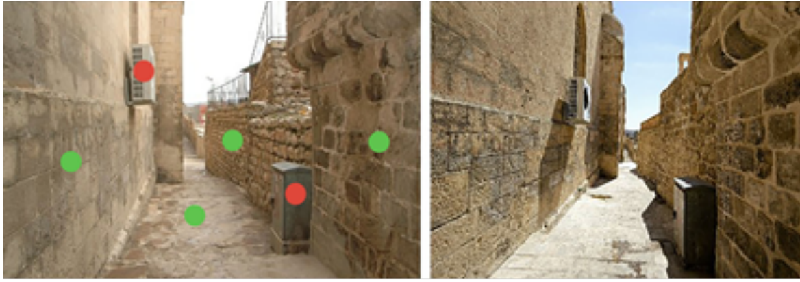
Resim 9. Tatlıdede Konağı ve Ulu Cami güzergâhında sağıklaştırma uygulamaları (Bakınız Tablo 2, (●) yapıldı; (●) kısmen yapıldı; (●) yapılmadı), öncesi (sol) ve sonrası (sağ) (Acay 2024: 74).
