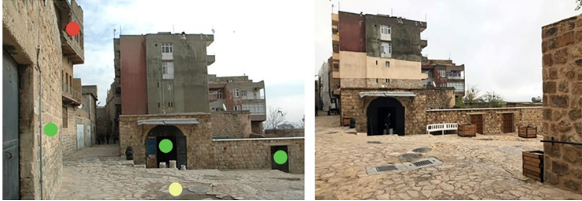
Resim 6. Protestan Kilisesi ve Latifiye Cami güzergâhında sağıklaştırma uygulamaları (Bakınız Tablo 2, (●) yapıldı; (●) kısmen yapıldı; (●) yapılmadı), öncesi (sol) ve sonrası (sağ) (Acay 2024: 67).
