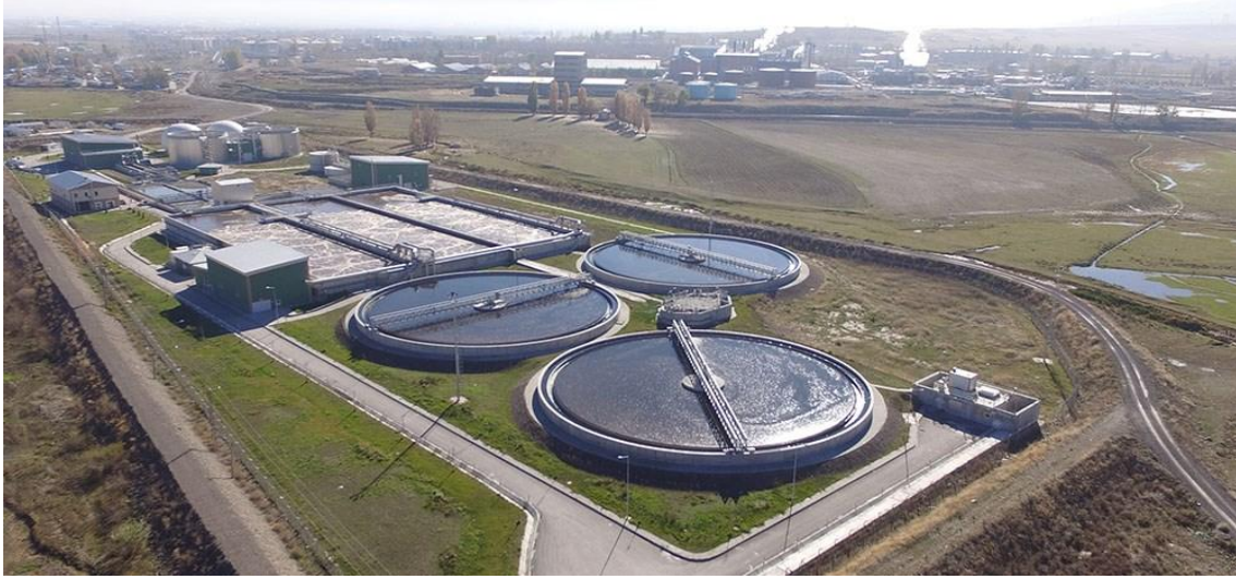
Şekil 1. Erzurum BAAT görüntüsü (Google Earth 2022). (general view of Erzurum BWWTP (Google Earth 2022))
