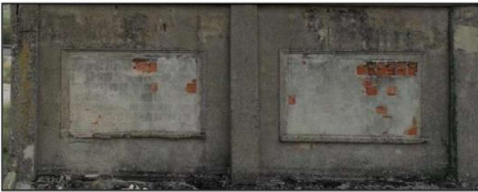
Şekil 19.a. Kuzeybatı Cephesinde Kapatılan Açıklıklar 19.b Kuzeybatı Cephesinde Kapı Bezemeleri (Bayram, 2024).
