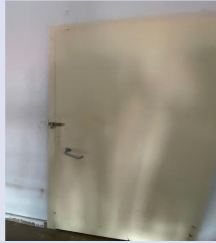
Şekil 5. Çatı katı giriş kapısı Figure 5. Attic entrance door
