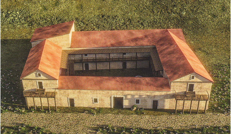
Levha 4: Döşemealtı Mansio restorasyonu (Mitchell vd. 202, fig. 57)
