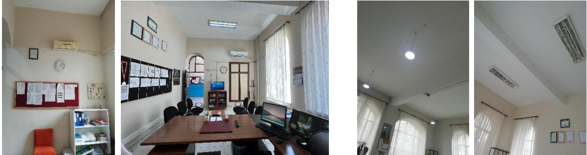
Resim 10. Duvarlarda Yapılan Çeşitli Uygulamalar; Tavanda Yer Alan Çeşitli Aydınlatma Elemanları (Yazar Arşivi, 2022)
