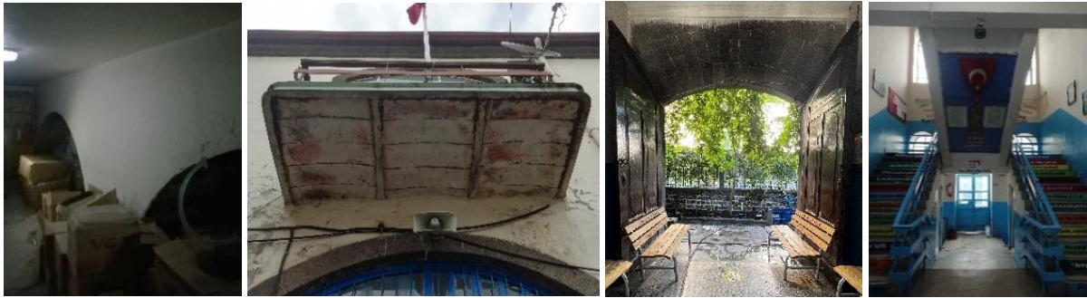
Resim 6. Bodrum Katta Yer Alan Özgün Kemerler; Balkonda Yer Alan Özgün Volta Döşeme; Anıtsal Giriş Kapısı; Üç Kollu Merdiven (Yazar Arşivi, 2022)
