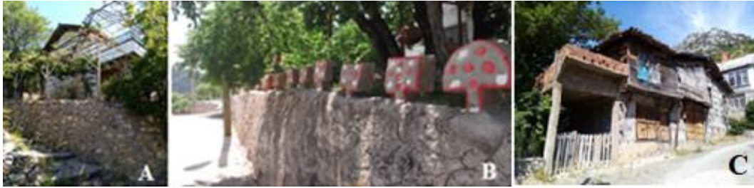
Fotoğraf 4. Avlu/bahçe duvarı A.116A/2P, B.120A/5P, C.108A/4P
