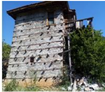
Fotoğraf 9. Zemin kat havalandırma penceresi 112A/17P
