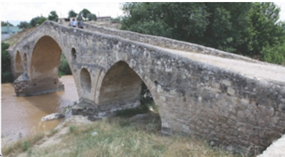
Fotoğraf 4: Gravga Köprüsü menba cephesi; A) Güney yakadan görünüm. (Dayar, 2017, s.167) B) A3 ayağı bünyesinde gözler, yeniden inşa izi, örgü farklılıkları. (2020)
