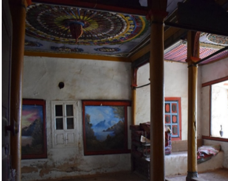
Fotoğraf 8: Doğu Duvar
