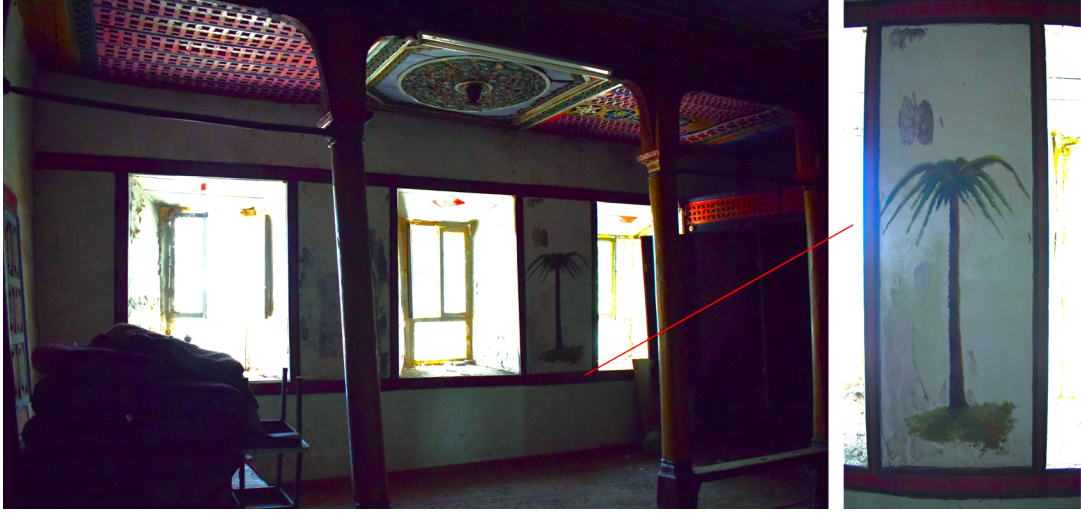
Fotoğraf 9: Güney Duvar
