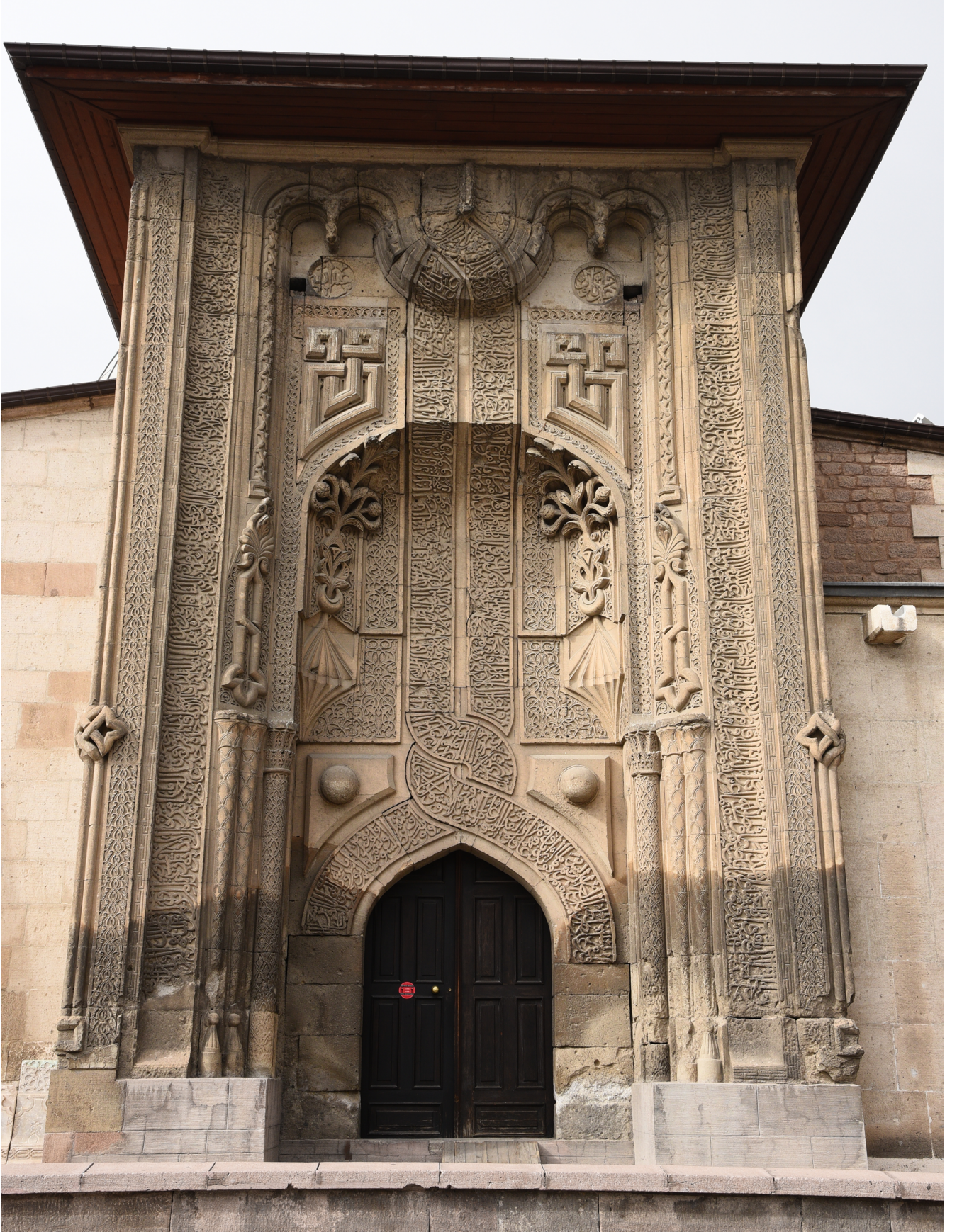
Fotoğraf 2: İnce Minareli Medrese-Taçkapı
