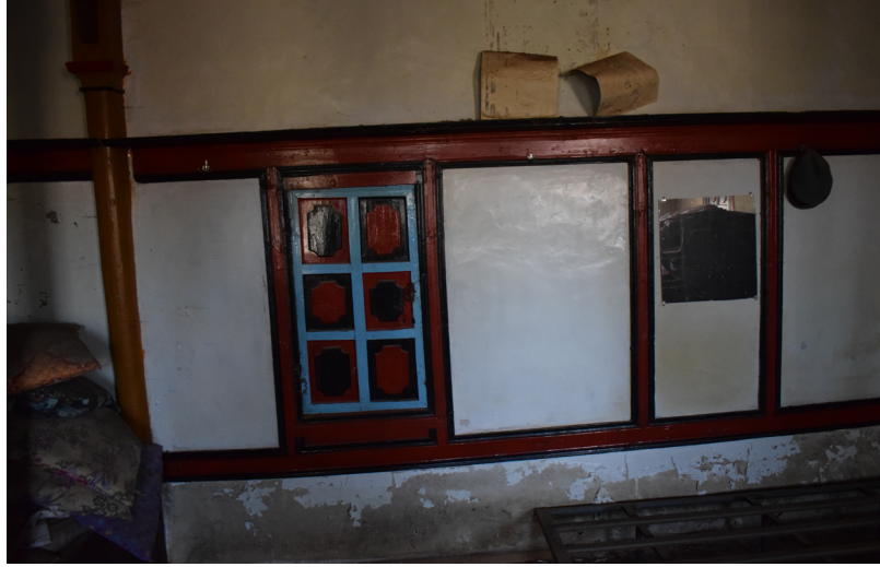
Fotoğraf 7: Kuzey Duvar
