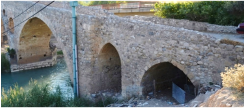
Fotoğraf 3: Gravga Köprüsü mansap cephesi, kuzey bölümü. (2020)
