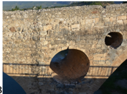
Fotoğraf 4: Gravga Köprüsü menba cephesi; A) Güney yakadan görünüm. (Dayar, 2017, s.167) B) A3 ayağı bünyesinde gözler, yeniden inşa izi, örgü farklılıkları. (2020)
