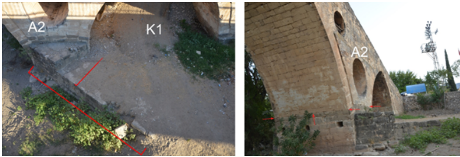
Fotoğraf 7: Gravga Köprüsü, A2 ayağı, koruma duvarı, platform ve onunla bütünleşik selyaran. (Menba tarafı. 2020)
