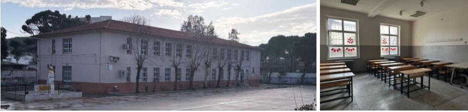
Resim 16. Menemen Ortaokulu ek derslik binası (solda) ve derslik (sağda) (Taşcı, 2024)
