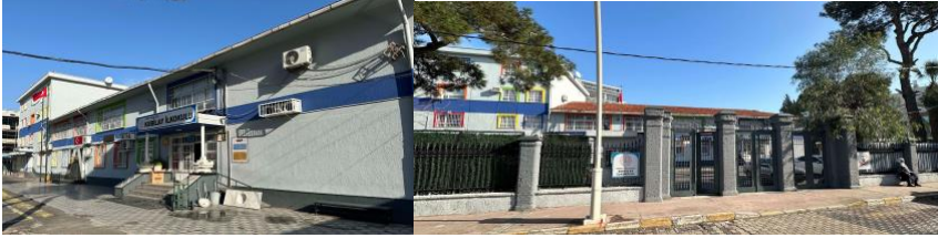
Resim 11. Kubilay İlkokulu giriş cephesi (solda) ve özgün bahçe duvarı ile giriş kapısı (sağda) (Taşcı, 2024)
